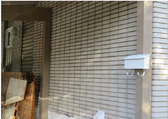
Exemple d'un mur de brique disposée de façon rectiligne avec des joints très profonds. 166, rue des Îles-Percées. Img_4804.jpg
