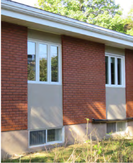
Traitement différent du revêtement au-dessus et au-dessous des fenêtres latérales. 134, rue des Îles-Percées. IMG_4732.jpg
