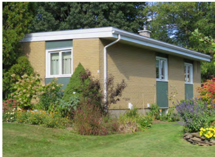
Traitement différent du revêtement au-dessus et au-dessous des fenêtres latérales. 120, rue des Îles-Percées. IMG_4698.jpg
