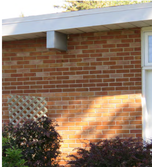
Extrémité de chevron apparente. 94, rue des Îles-Percées. IMG_4645.jpg
