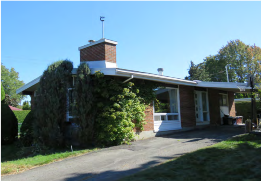
La façade principale du 104, rue des Îles-Percées fait face à la rue De La Saudrays, mais la maison possède tout de même son adresse sur la rue des Îles-Percées. IMG_4653.jpg
