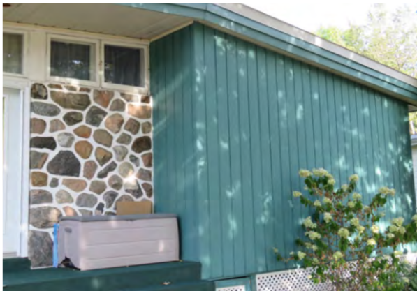
Avant-corps du 184, rue des Îles-Perçées. IMG_4828.jpg.
