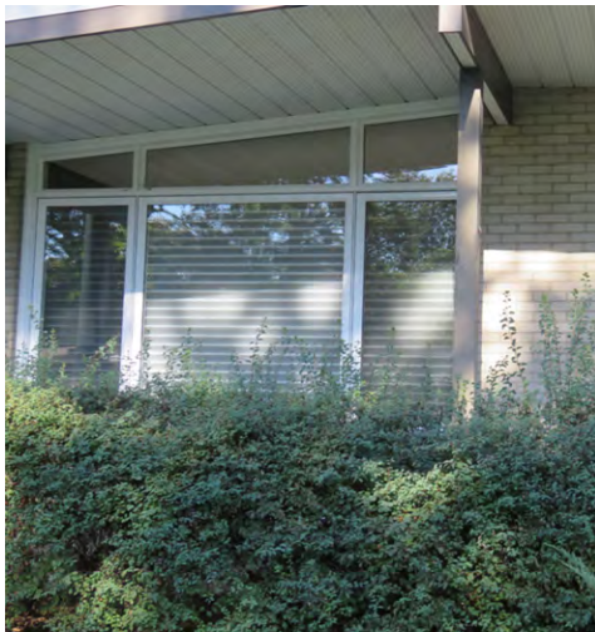
Imposte au-dessus d'une fenêtre composite en façade avant. 142, rue des Îles-Percées. IMG_4749.jpg
