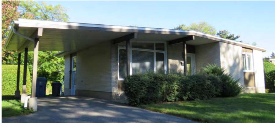
Imposte au-dessus d'une fenêtre composite en façade avant. 142, rue des Îles-Percées. IMG_4746.jpg
