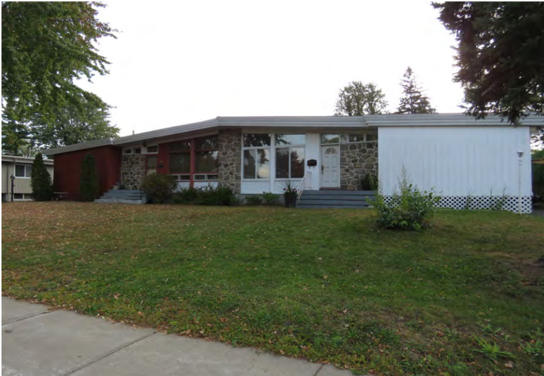
Le 232-234, rue Louis-J.-Lafortune, un des édifices de la zone d'étude, datant de 1962. IMG_5298.jpg
