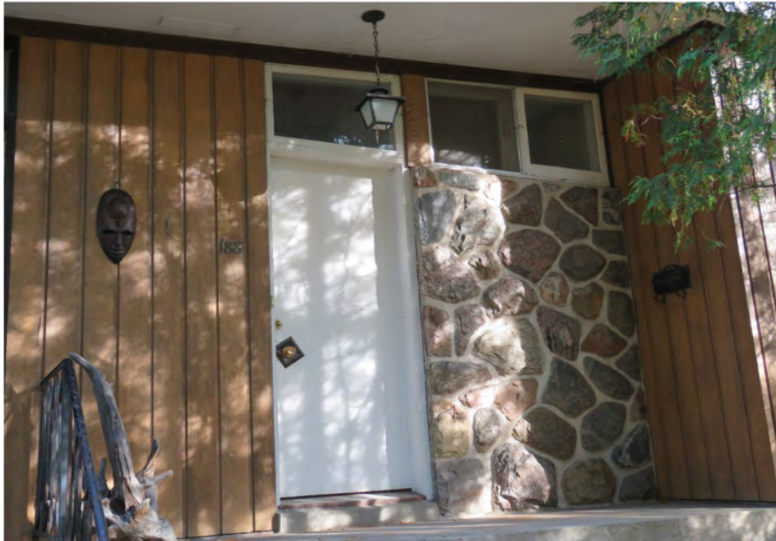
Impostes au-dessus de la porte d'entrée et d'une section du mur en pierre. 188, rue des Îles-Percées. IMG_4840.jpg
