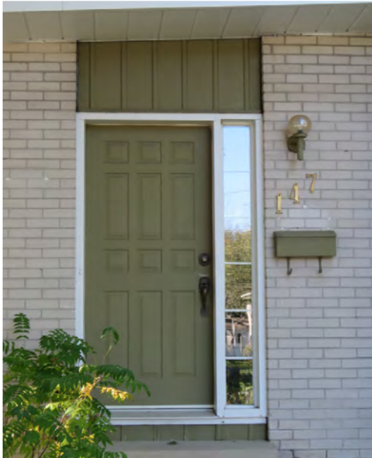
Baie latérale de porte. 147, rue des Îles-Percées. IMG_4945.jpg
