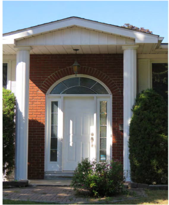
Imposte à arc plein cintre et perron couvert d'un toit à pignon supporté par des colonnes. 233, rue Louis-J.-Lafortune. Img_5088.jpg
