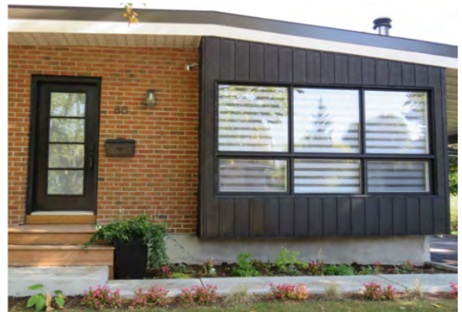
Avant-corps du 86, rue des Îles-Perçées. IMG_4624.jpg
