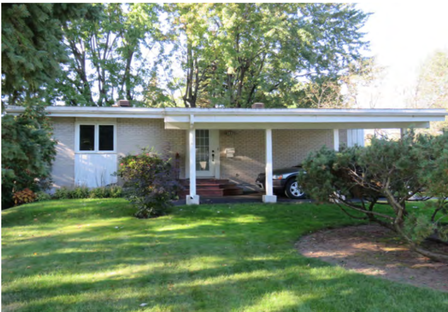
Côté de l'abri d'auto du 127, rue des Îles-Percées, qui fait face à la rue des Îles-Percées. Sa façade principale donne sur la rue Claude-Dauzat. IMG_4909.jpg
