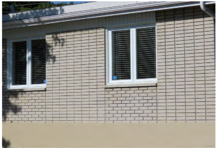
Traitement différent de la brique au-dessus et au-dessous des fenêtres latérales. 154, rue des Îles-Percées. Img_4778.jpg
