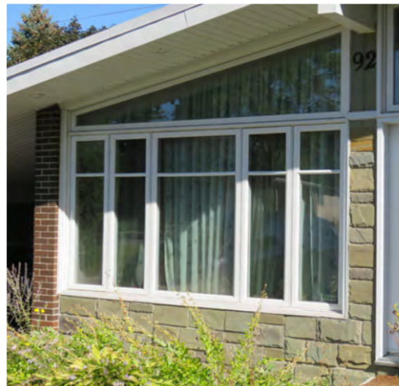
Imposte au-dessus d'une fenêtre composite en façade avant. 92, rue des Îles-Percées. Img_4637.jpg
